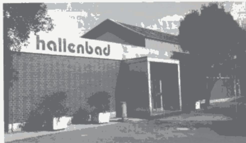
Das Hallenbad in Rodenkirchen
